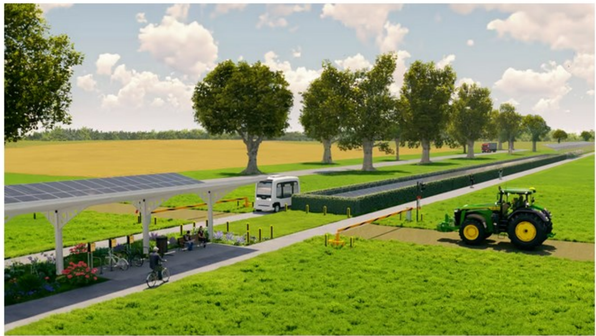
Der Radweg soll mit einer Spur für einen autonom fahrenden Acht-Sitzer-Bus gekoppelt und über die mittigen Photovoltaikanlagen finanziert werden, Grafik: 22. Trainpath GmbH
