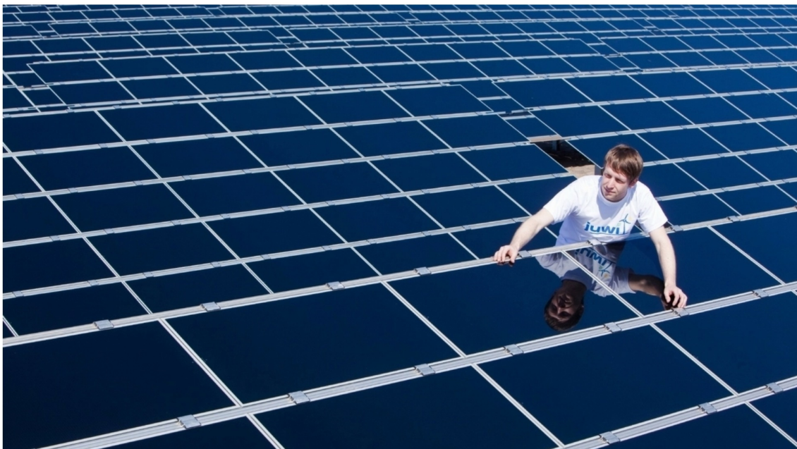
Strom dank Sonne: Auf dem ehemaligen Truppenübungsplatz Lieberose prüft ein Techniker fertig montierte Dünnschicht-Solarmodule. (Archivbild) In Mixdorf will sich ein Unternehmen jetzt autark mit Solarstrom versorgen. Wofür wird der Strom genutzt? (Symbolbild) © Foto: Patrick Pleul/dpa
